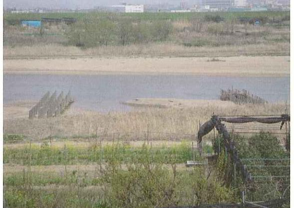
図 6・1・19 水制域への堆積状況 (2004. 4. 3)
