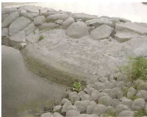
図6・2・17 水制基部上流側の堆積土砂
