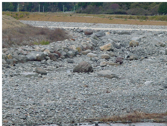
写真6.2.16 余笹川下川橋下流の河床状況 (2004年(平成14)11月9日)
