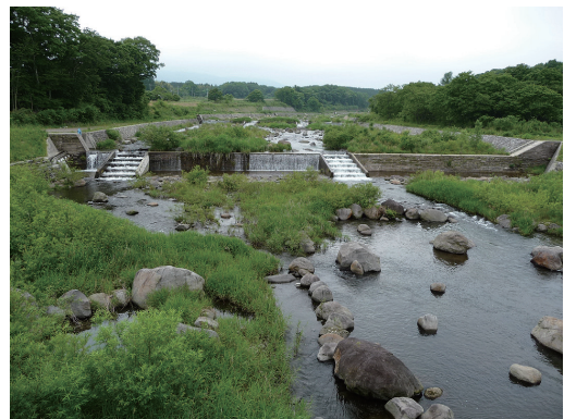
写真2.5.1 余笹川上流域の流路工 (2008年(平成20)6月撮影)
