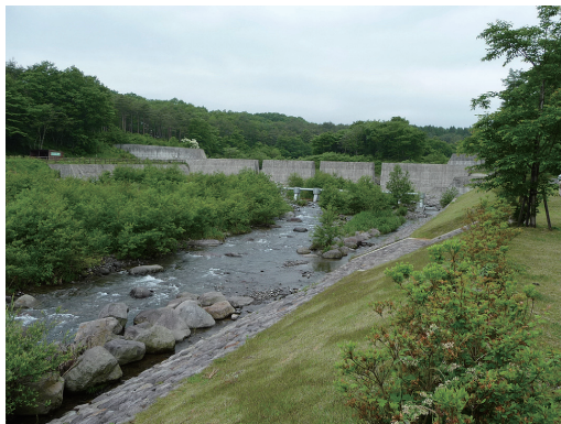
写真2.5.2 余笹川上流域の砂防堰堤 (2008年(平成20)6月撮影)
