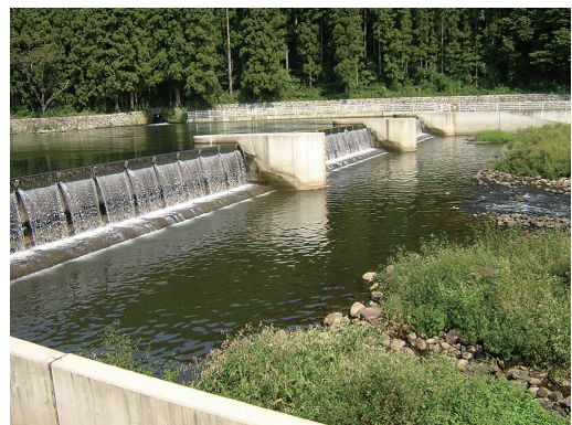
写真2.5.5 余笹川4.92km付近の取水堰 (2008年(平成20)6月撮影)
