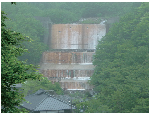
写真2.5.4 余笹川山地上流部(北温泉)付近の砂防ダム(2008年(平成20)6月撮影)
