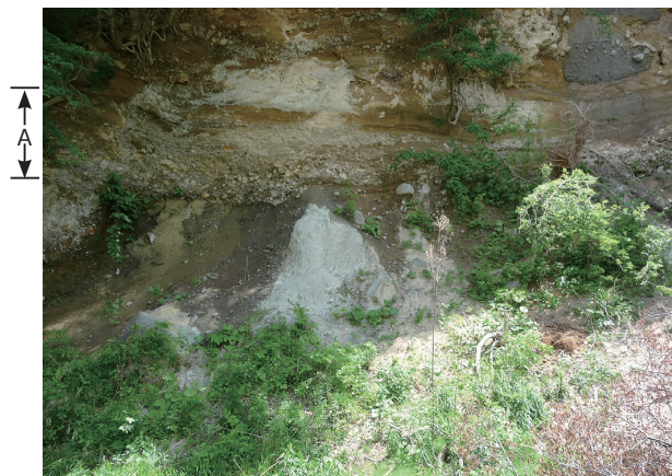
写真3.1.8 余笹川左岸3.1km付近の侵食崖 （2009年（平成21）5月撮影）、A：鍋掛礫層
