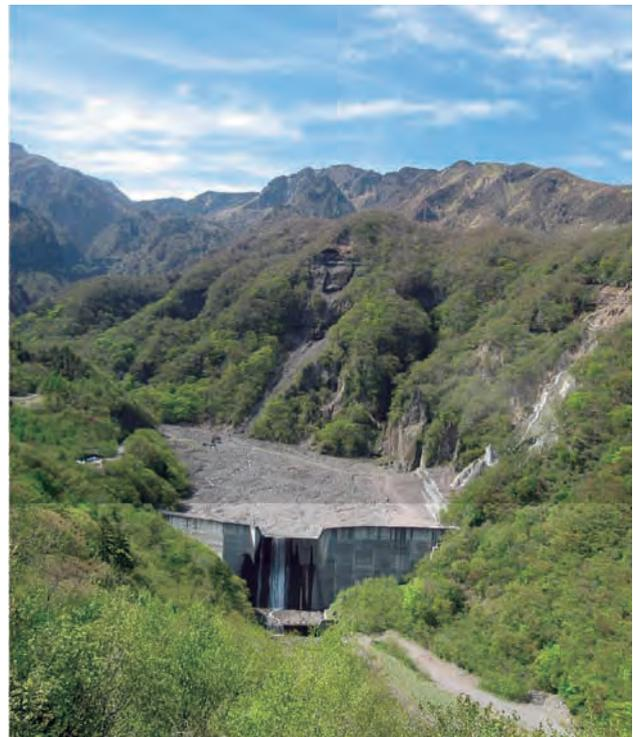
写真 2.2.1 女峰山と日向砂防堰堤の堆積土砂
