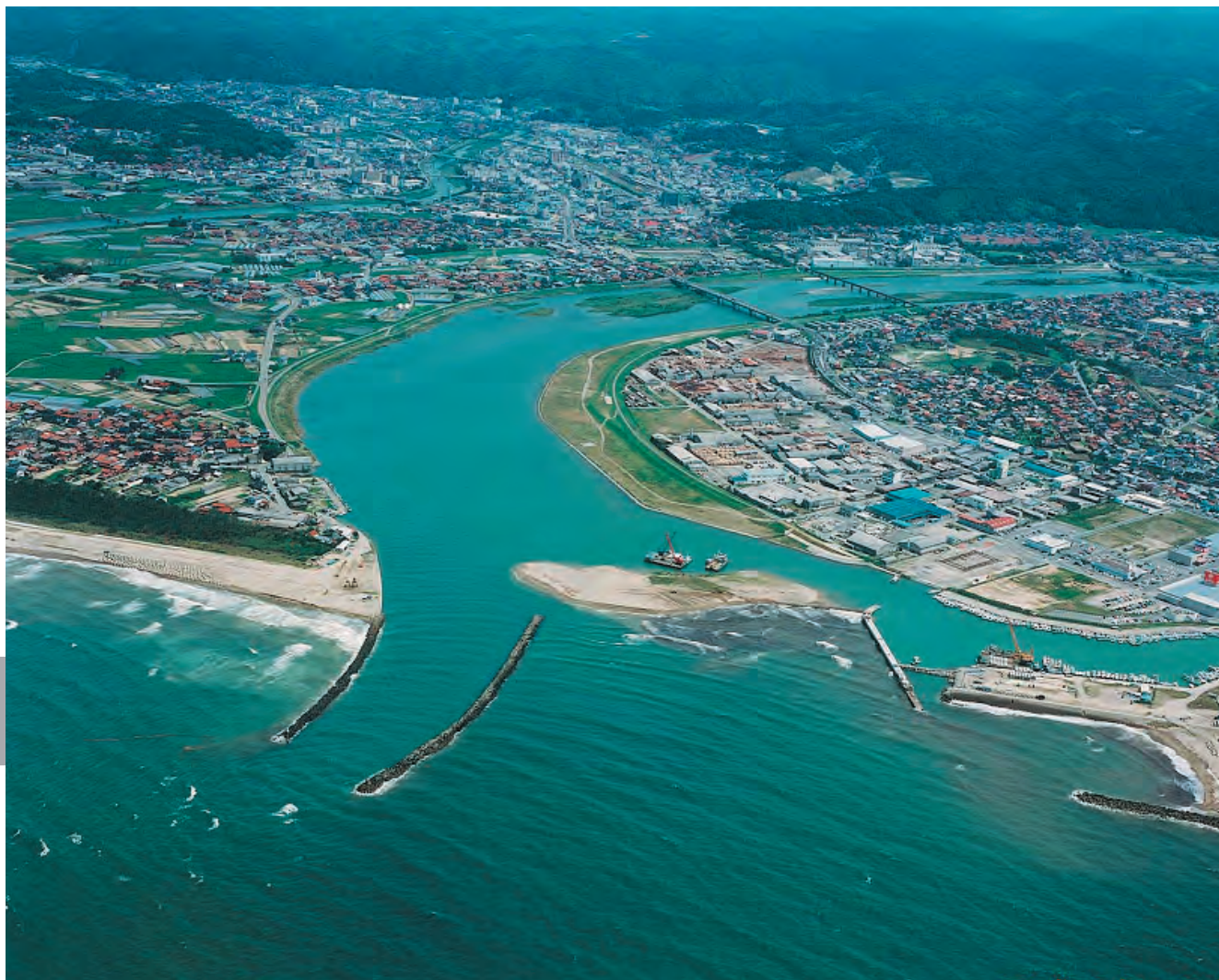
浜田河川国道事務所 撮影 (2003年)
