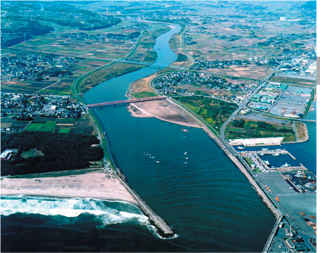
常陸河川国道事務所 撮影
