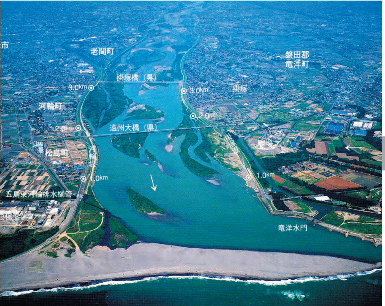
浜松河川国道事務所 撮影
