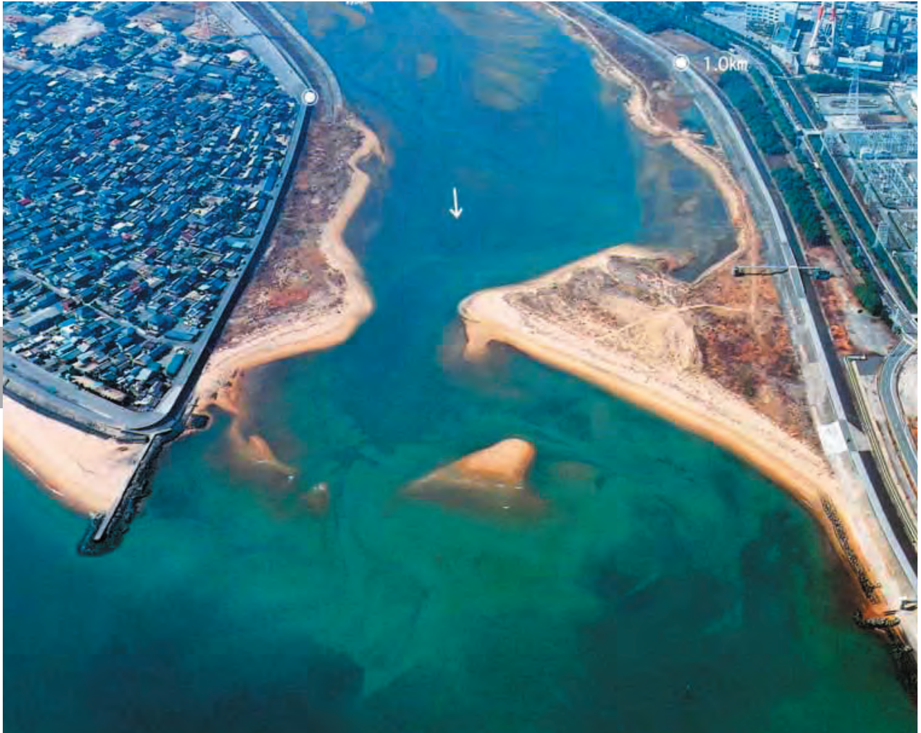
三重河川国道事務所 撮影
