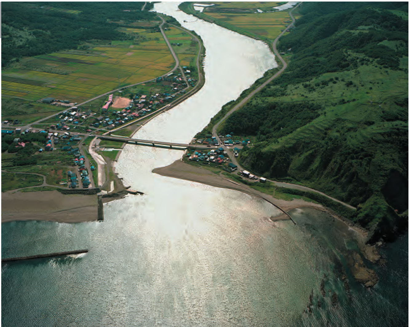
小樽開発建設部 撮影
