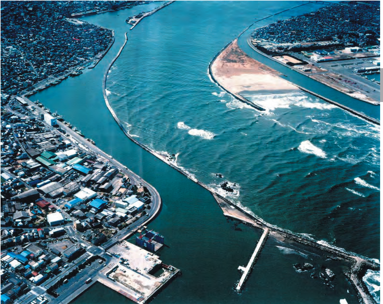
利根川下流河川事務所 撮影
