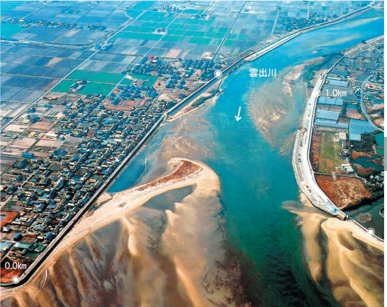
三重河川国道事務所 撮影
