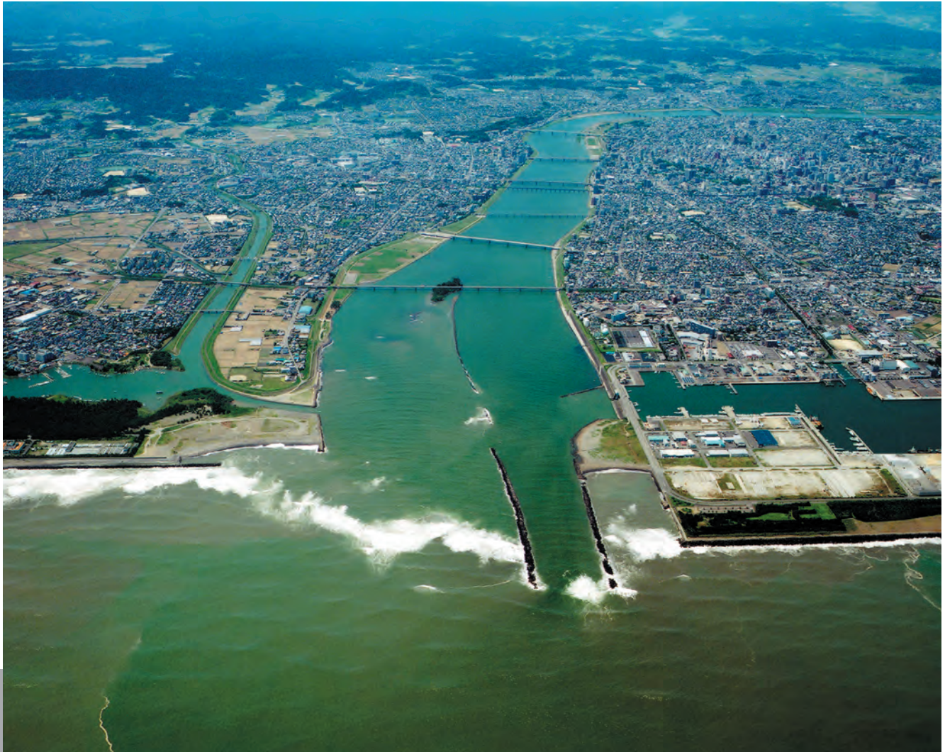
宮崎河川国道事務所 撮影 (2006年)
