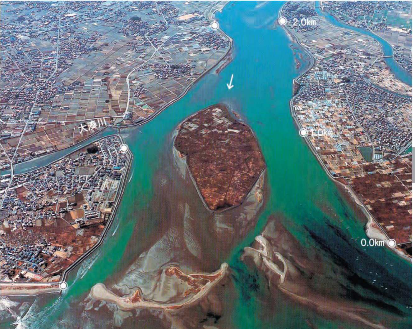
三重河川国道事務所 撮影
