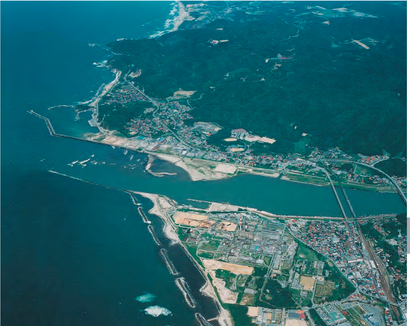
浜田河川国道事務所 撮影 (2003年)
