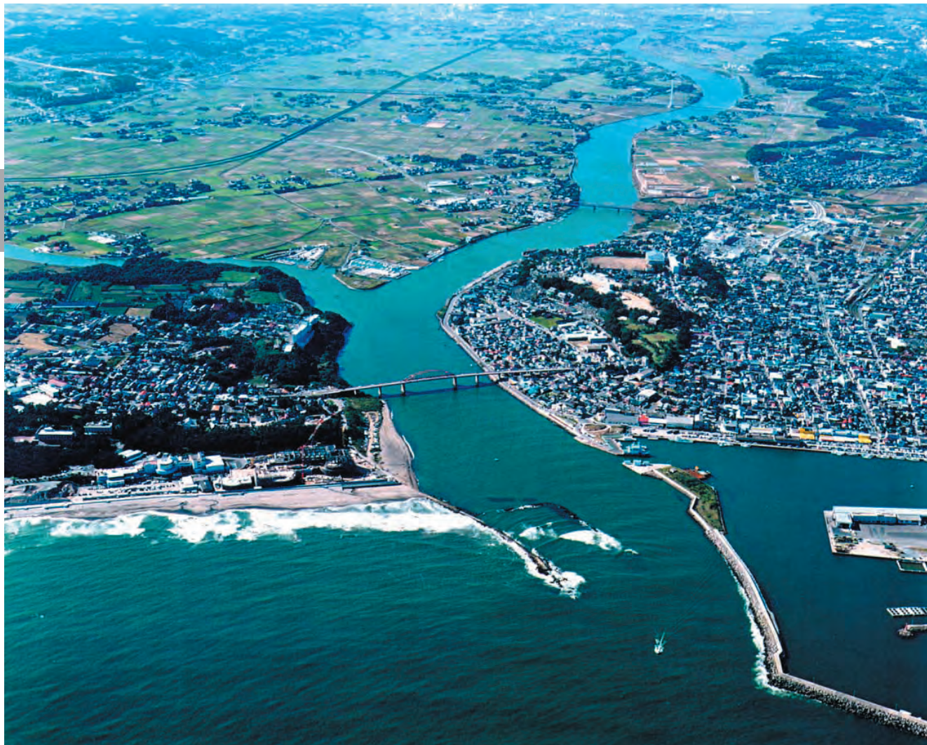
常陸河川国道事務所 撮影
