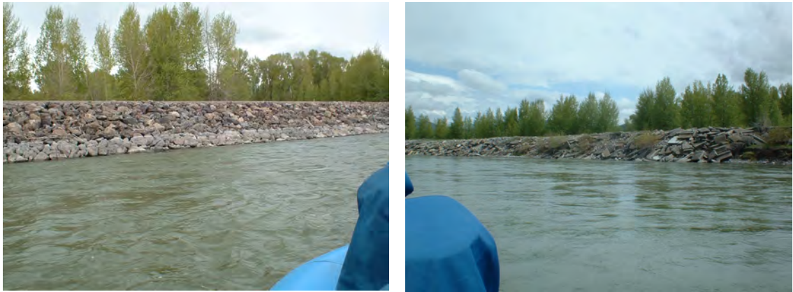
写真-55、56 岸辺の管理は国家森林局 (National Forest Service) (左：丸石護岸、右：コンクリート破片を使った護岸)
