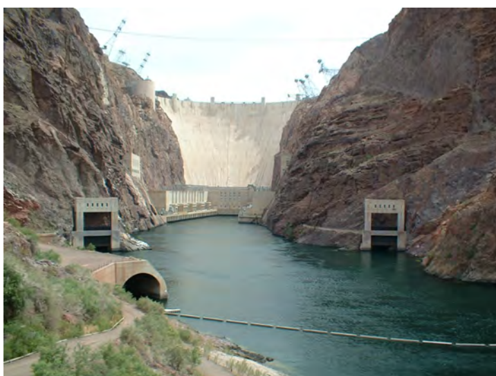
写真-23 フーバーダム下流(上流側四角形は利水放流管、下流側アーチ型-左右にある-は洪水吐)
