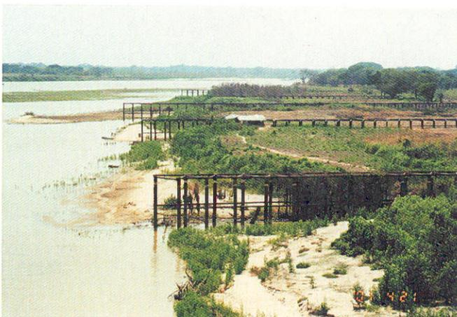
写真4・1 ブルスアル左岸の鋼製パイル水制
