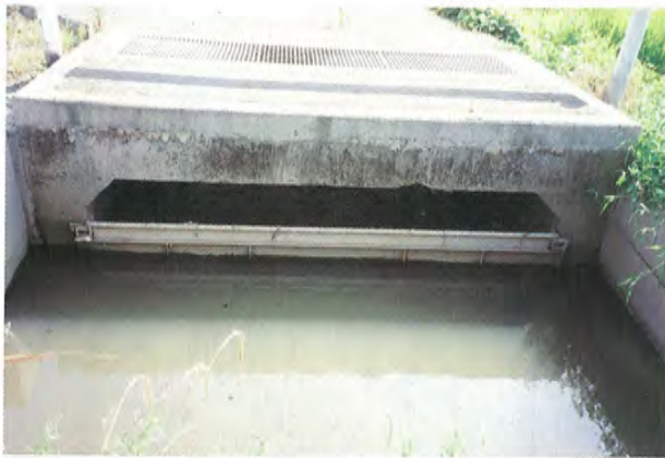
①排水路取水部
