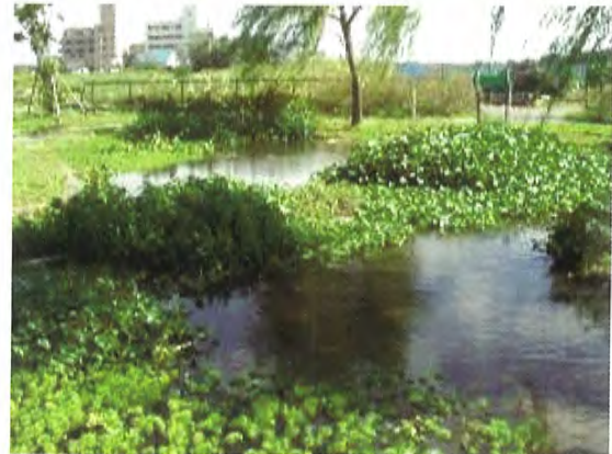
④植生浄化池
