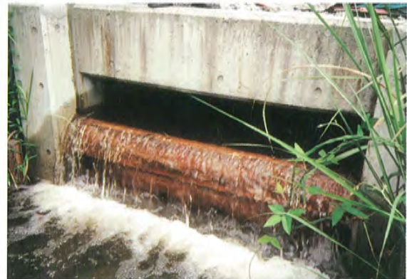
流れ込み部 (西ブロック)
