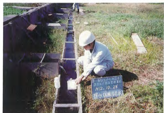
④各槽からの放流部
