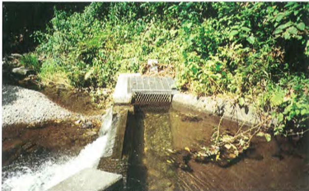
①取水部は堰が設けられ塩ビパイプで導水
