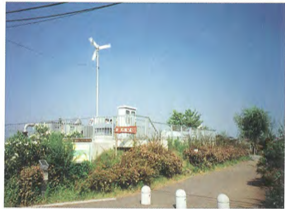
②高負荷生活排水処理施設 と風力発電
