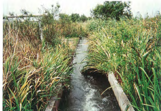
導水路 (右が植生槽)
