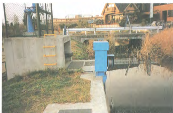
①河川取水部
