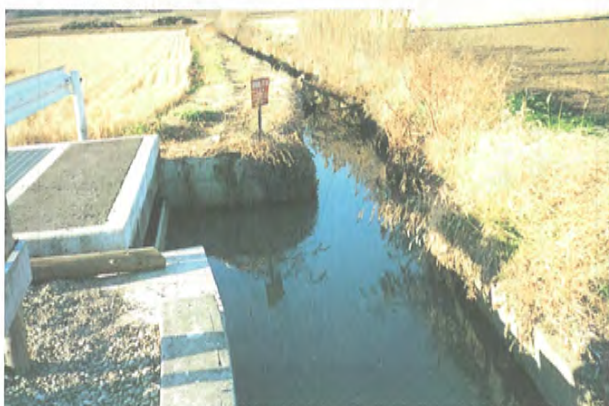
①排水路取水部
