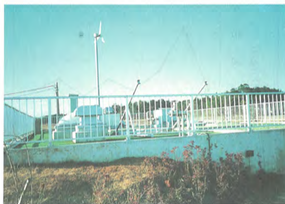
②高負荷生活排水処理施設 と 風力発電
