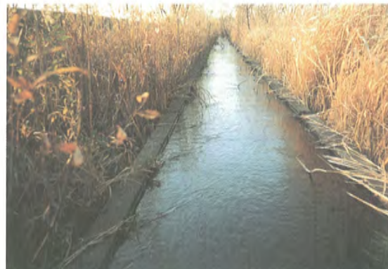
②導水路(右が植生槽)
