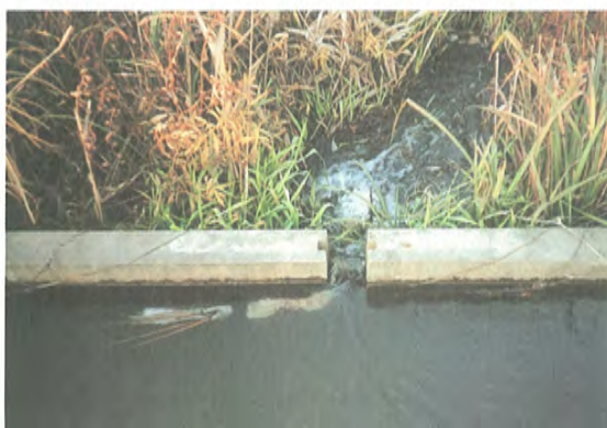
③槽流入部(手前が導水路)
