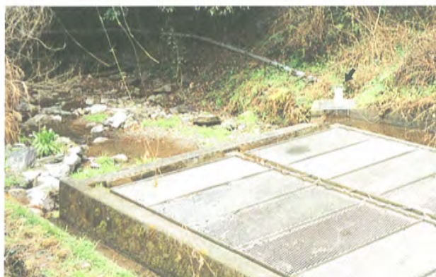
①取水部は堰が設けられ、塩ビパイプで導水。
