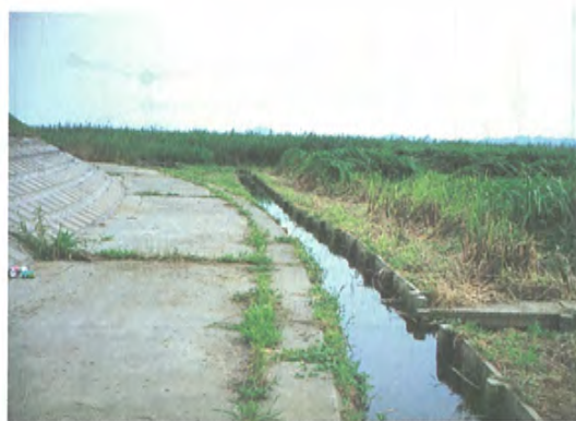
② 導水路(流入共通水路)
