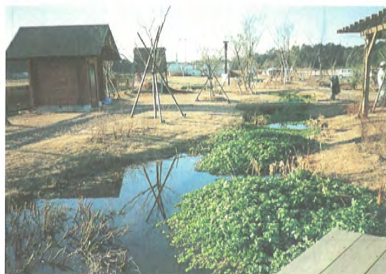
③植生浄化池流入部
