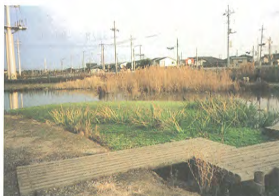
③植生浄化施設 (手前オオフサモ、キショウブ、奥はヨシ)
