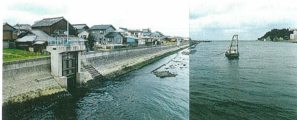
▲ 放流樋管及び遠賀川河口部
