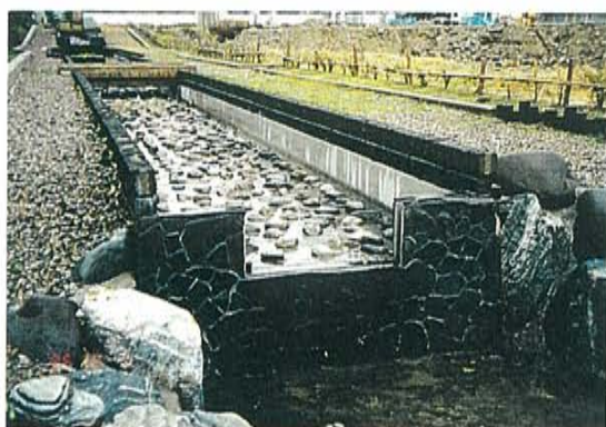
▲ 補給水水路①
