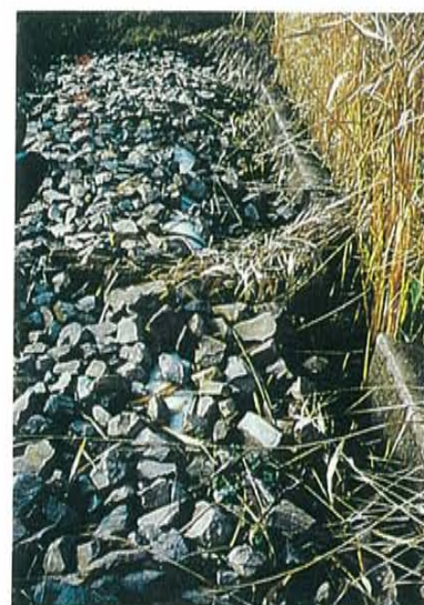
▲ 植生酸化池 流出部
