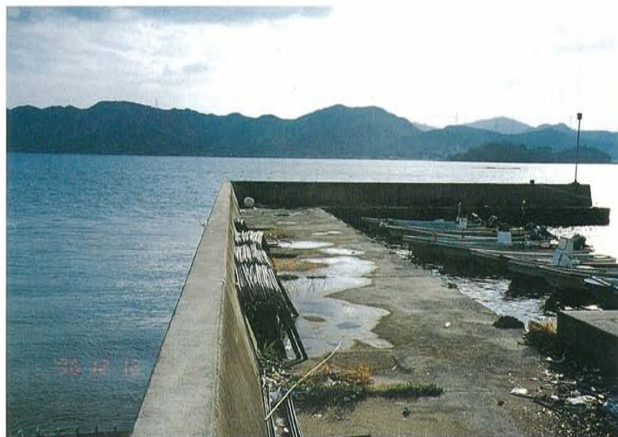
▲ 船だまりの突堤（直下に放流管敷設）
