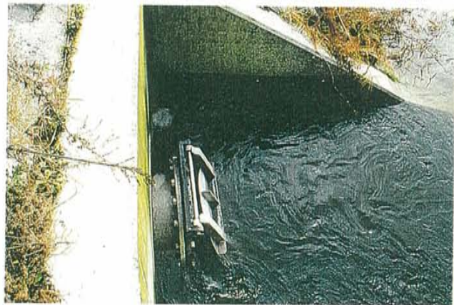
▲ 放流樋管出口（満潮時）
