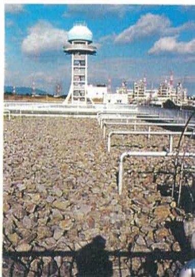
▲ 曝気付礫間接触酸化池
