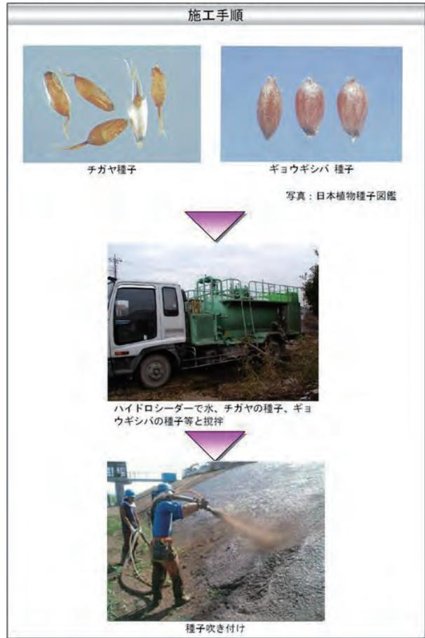
図 5・2(2) 堤防植生試験施工計画（案）
