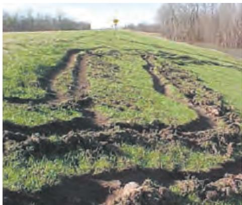
写真 6・3 堤防法面への車両の乗り入れ跡<sup>7)</sup>
