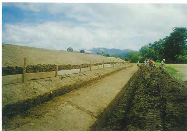
写真3・2 法尻および水平埋込部掘削状況
