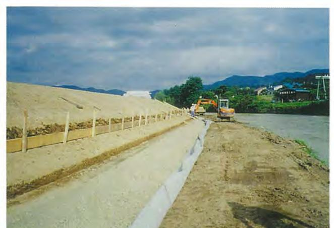
写真3・3 法尻シート敷設後の裏込み砂利敷設状況
