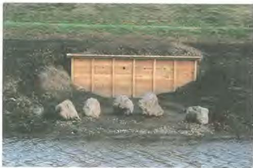
写真 5・1 木材板壁の人工営巣構造物
