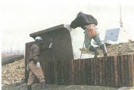
写真 4・3 カワセミ人工営巣ブロックの設置状況
