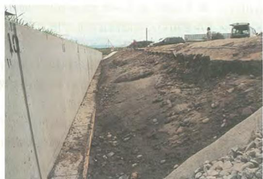
写真4(i) 通水後の法面の状況
