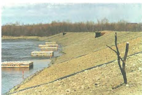
写真 4・4 工事完成直後の多自然型河岸状況
