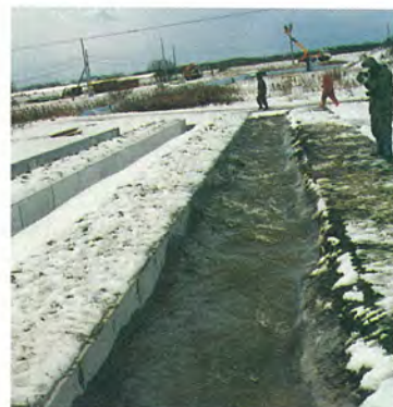
写真4 実験2の流況 (流量1.0m³/s)
