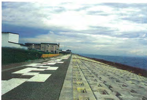
写真5 緩傾斜護岸と植栽を施した
