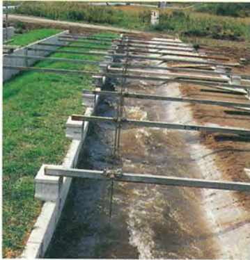
写真1 実験1の流況 (流量1.0m³/s)
