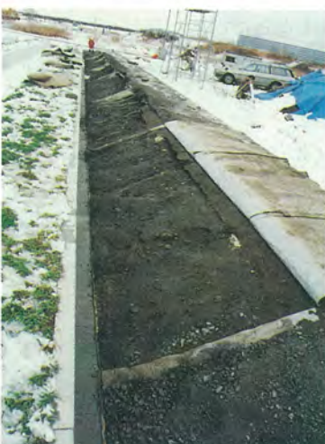
写真6 通水後の法面状況 (実験2)
