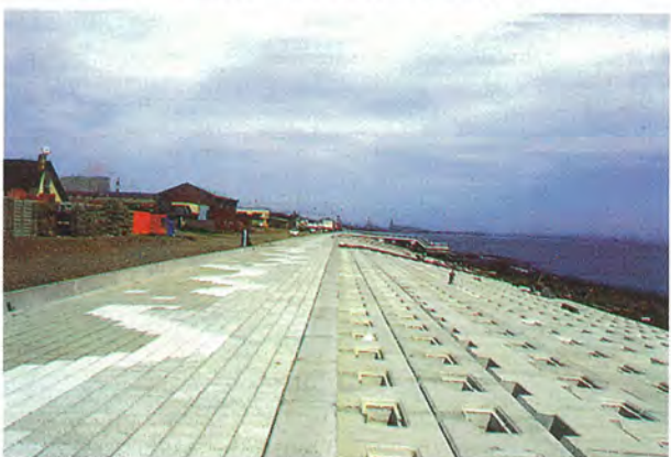
写真7 自然性が低かった緩傾斜護岸
