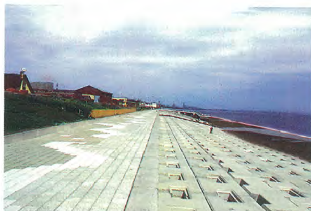
写真9 植栽を施し、緩傾斜護岸に砂浜を付けた
