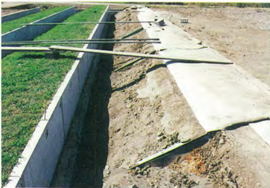
写真3 通水後の法面状況 (実験1)
