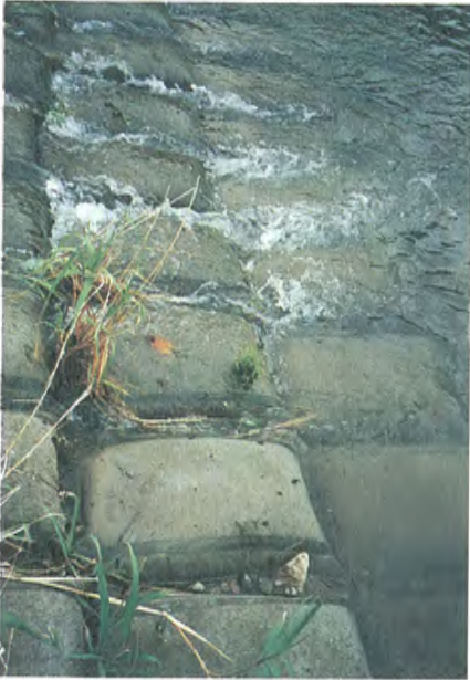
写真2 テンダーバックの敷設後の状況（完成後 1年6ヶ月）
