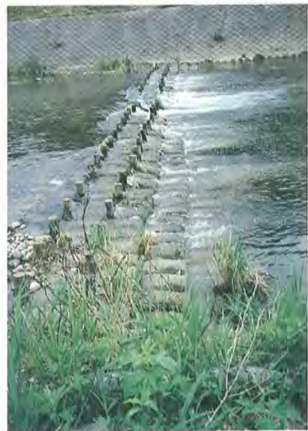
写真1 テンダーバックによる床固工の改築
