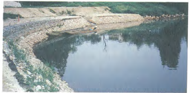
写真6 テンダーバックによる天端保護工（完成後3カ月）
