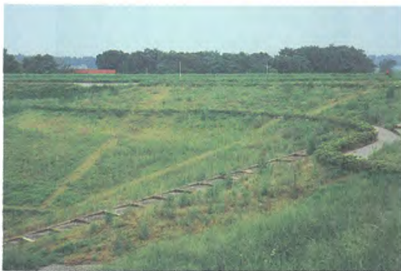
写真4 雨水排水機能の確保（完成後3カ月）
