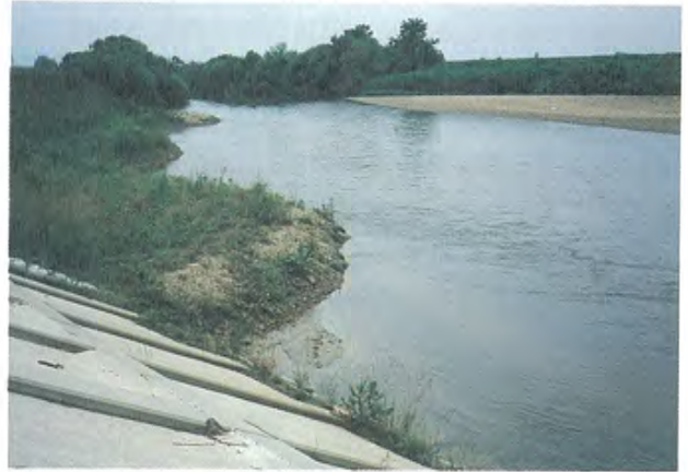
写真5 テンダーバックによる法覆工（完成後3カ月）
