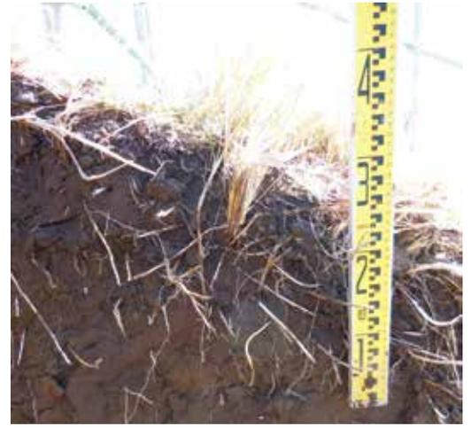
図14 堤防表面30cm程度の植生基盤土質に着目した対策
