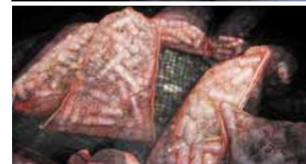
写真⑥ 微生物の浄化作用を利用して川の水をきれいにする施設が全国の川で活躍している。礫(れき)の間を水が通ると微生物が有機物を食べて汚れをとる(上)。礫のかわりに乳酸菌飲料の容器を利用した浄化施設(26~29ページ参照)もある(下)。
