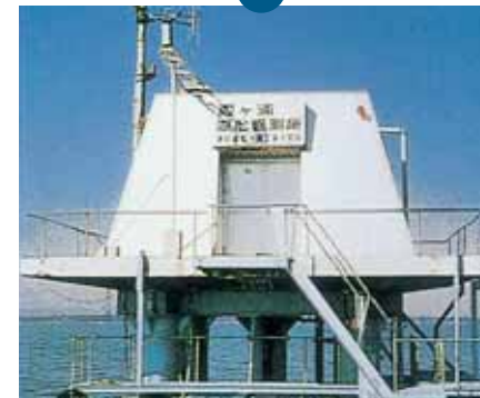
写真⑪ 霞ヶ浦の水質の見張り番、湖心観測所。川や湖には水質を常時監視している観測所が設置されている。 写真提供/国土交通省関東地方整備局霞ヶ浦河川事務所
