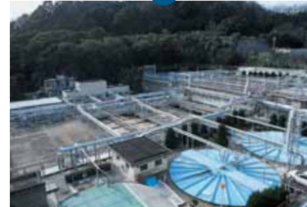
写真③ 下水処理場では家庭や町から出る排水をきれいに処理して川に流し、川の水質汚濁を防止している。
