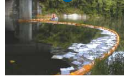
写真⑨ 油流出事故が起きるとオイルフェンスを張って下流に油が流れるのを防ぎ、オイルマットに油を吸収させて汚染の拡大を防ぐ措置がとられる。 写真提供/宮城県仙台土木事務所
