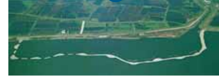
写真⑮ 霞ヶ浦へのリンや浮遊物質の流入を防ぐために、川尻川河口に整備された湖内湖。湖沼に流れこむ川の河口に人工湖(湖内湖)をつくり、川から流れ出すリンや浮遊物質をそこにためて、湖の水質をまもる。リンや浮遊物質がたまった湖内湖の底泥は数年一度とりのぞく。写真提供/国土交通省関東地方整備局霞ヶ浦河川事務所
