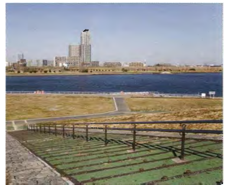
● 東京都と埼玉県の間を流れる荒川には、洪水による水害から流域の町をまもるために、幅が広く、高い堤防が築かれている。
