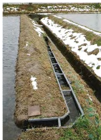
●水田と排水路のあいだに設置された水田魚道。水田、水路、川が魚道でむすばれることで、魚が川から水田まで自由に行き来できる。
