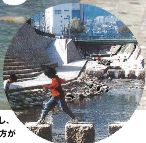
●神戸市灘区を流れる都賀川。ふだんは子どもたちも遊びにくる川、緊急時には都市災害から市民をまもる川づくりが実現された。 [写真提供／兵庫県]
