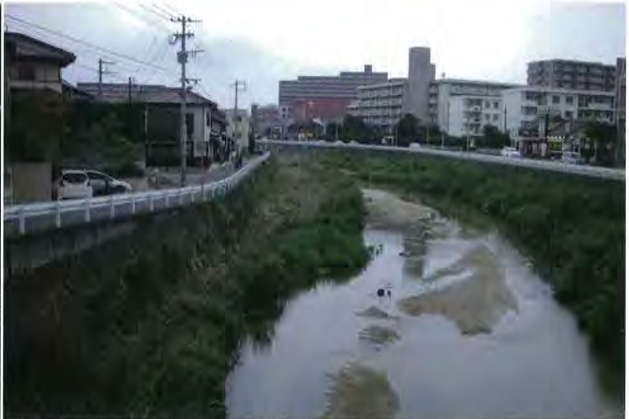
●田島橋下流を流れる樋井川のふだんの水量は護岸よりずっと低い(上)。しかし2009年7月24日夜、樋井川は増水し、左の写真のように左岸側は護岸を越えて水があふれた(写真は下流側から撮影)。 〔左の写真提供/福岡県〕
