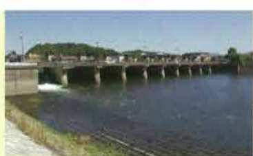
●瀬田川洗堰（せたがわあらいぜき）。1961（昭和36）年完成の2代目洗堰。琵琶湖から流れだす瀬田川の流量をコントロールし、洪水や渇水時の水位および水量調節を目的にしている。
