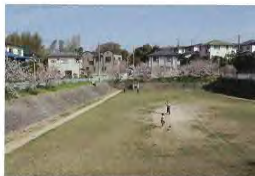
●農業用のため池を福岡市が整備した治水池、田島新池。約1,100tの水をためることのできるこの治水池は、晴天時、グラウンドとして利用されている。[写真提供／福岡市]
