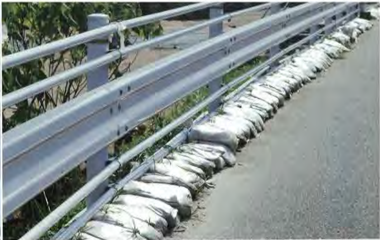
●次の出水に備え、福岡県によって、堆積した土砂を取り除き川の水が流れやすくなる浚渫（左）と土のうを積み応急措置がおこなわれている（右）。[左の写真提供／福岡県]
