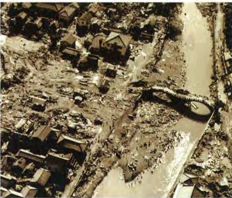
●諫早水害では本明川に架かる石橋の眼鏡橋の兩岸で、橋が流れをせき止める形になり、濁流が民家を押し流した。[写真提供／諫早市]
