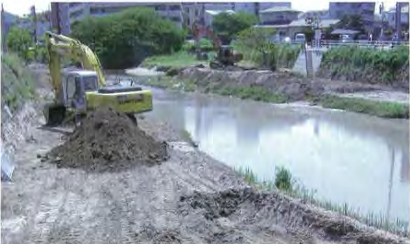
●次の出水に備え、福岡県によって、堆積した土砂を取り除き川の水が流れやすくなる浚渫（左）と土のうを積み応急措置がおこなわれている（右）。[左の写真提供／福岡県]
