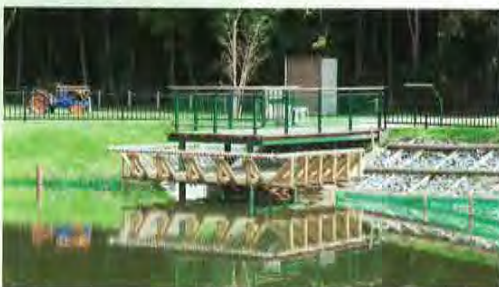
◀ため池の護岸の一部(画面右)は、生物にやさしい石積み護岸で整備。そのほかの法面は植生で覆って緑にあふれる。
