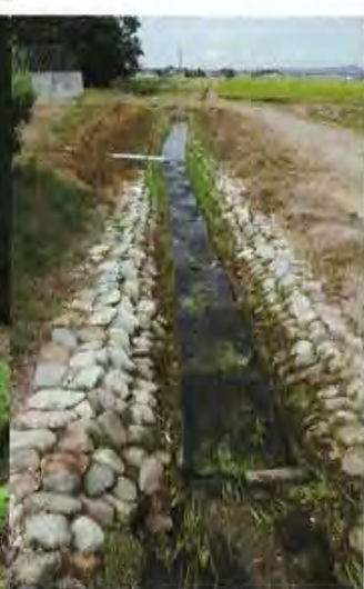
●湧水は農業にも利用されている。その1つ、美郷町土崎地区の大清水湧水（左）は、水路の護岸を石積みにし（上）、イバトミヨなど生物が生息しやすい環境を整備している。
