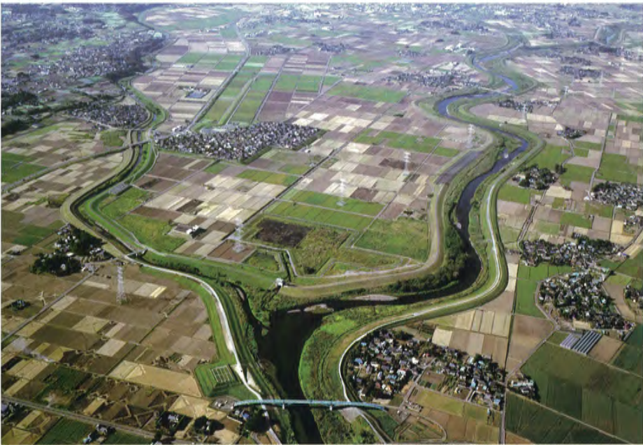
●遊水地内につくられた新しい町。1986年の洪水で被害の大きかった茨城県筑西市母子島(はこじま)地区は、小貝川の治水のため遊水地として整備され、もともとあった5集落は遊水地内の高台に移転し、新しい集約型の町がつけられた。[写真提供/国土交通省関東地方整備局下館河川事務所]
