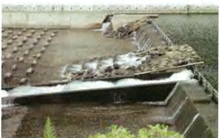
●堰の魚道は河川の連続性の確保にとって重要。円山川水系では改修、整備が進む。
