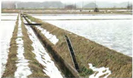
●水田と排水路のあいだに設置された水田魚道。こうした魚道に加え、川と水路の接続部分にも魚道がつくられることで川から水田まで魚が自由に行き来できるようになる。
