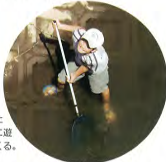
●水田と排水路のあいだに設置された水田魚道。こうした魚道に加え、川と水路の接続部分にも魚道がつくられることで川から水田まで魚が自由に行き来できるようになる。
