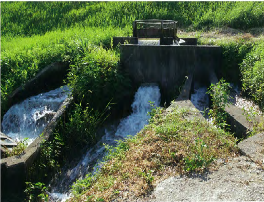
●円筒分水。上に築かれた「大池」の水を、この施設を使って4本の用水路に分水し、最終的には5地区に送る仕組みになっている。
