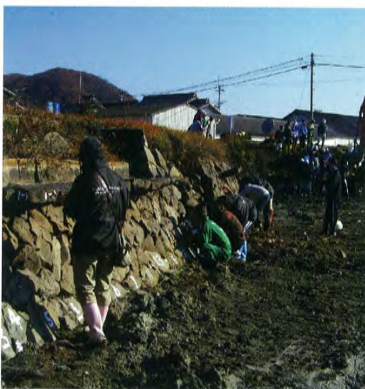
●水を抜いたため池に入り、石積みの護岸や水利機能を調べる国立明石工業高等専門学校の学生たち。地元の水利組合の協力を得て、加古川市志方町のため池の構造を調査している。[写真提供/国立明石工業高等専門学校]
