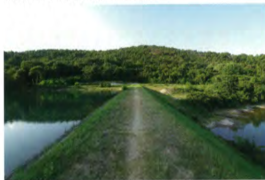
●谷をせき止めて築かれた志方町成井地区の「奥の池」は、上と下にふたつのため池がある「重ね池」という形のため池(写真上)。「奥の池」の奥に小池の堤体が見える(写真下)。周囲にはサクラが植えられ、春には花見でにぎわう。
