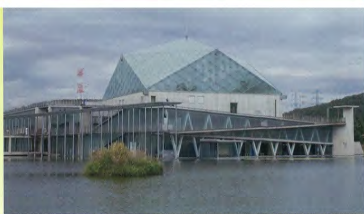
▲「なかがわ水遊園」の「フィッシュバル おもしろ魚館」。「なかがわ水遊園」は栃木県大田原市を流れる那珂川のほとりにあり、「おもしろ魚館」は大池に面して水に浮かぶように建つ。
