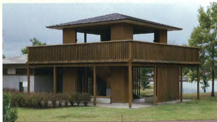
▲2階からは那珂川が眺められる休憩施設の「なかがわ展望台」。
