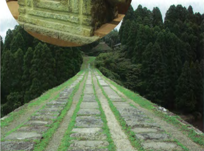
3列の通水管がならぶ通潤橋。ここを通過して白糸台地に水が送られる。 史料館では石造アーチ橋の通潤橋の建設のようすもわかる。
