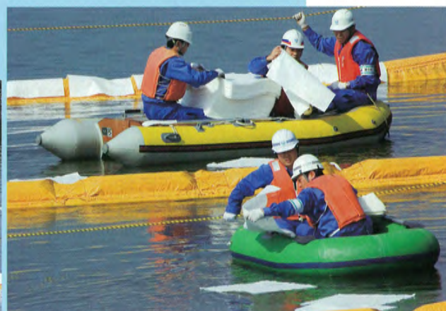
●オイルマットを敷設して油を吸着させ、除去する。
