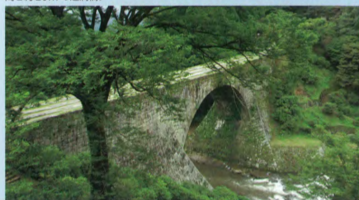
ふたつの台地をつなぐ 高さ約20mの通潤橋。
