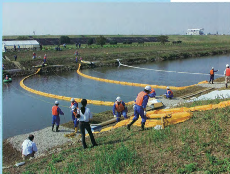
●油の拡散を防ぐためオイルフェンスを設置する。
