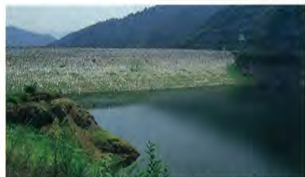
写真⑧ 有間ダム。荒川の支流、入間川に建設され埼玉県民の水がめになっている。
