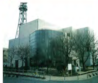
荒川知水資料館
