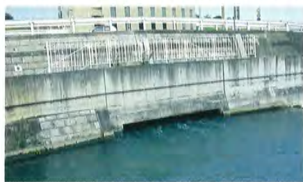
●古ヶ崎浄化施設できれいになった水は全長 2.5km の「ふれあい松戸川」を流れ、ここで坂川に合流し、3.5km 下流で江戸川に流れこむ。水の一部は坂川にもどり(写真右へ流れる)、坂川の水質浄化に役立っている。
