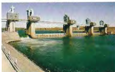
写真⑦ 秋ヶ瀬取水堰(あきがせしゅすいせき) 埼玉県を流れる荒川の下流に建設された取水堰。ここで取水された水は東京都や埼玉県の水道用水、工業用水などに使用される。 写真提供/水資源開発公団利根導水総合管理所
