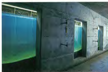
写真① 多摩川の支流、平瀬川の礫間接触酸化(れきかんせうし)よくさんか)浄化施設。川のなかの石(礫)の間を水が流れていくうちに、汚濁物質(川の水の汚れの原因になる物質)は川の底にたまって(沈殿)、石にくっついたり(吸着)、微生物のエサになったりして取りのぞかれ、水はきれいになる。この作用を応用して、たくさんの礫をつめた浄化槽のなかに川の水を流して水をきれいにしていく。
