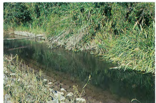
●水辺に親しみやすい傾斜の緩やかな護岸工事が施されている
