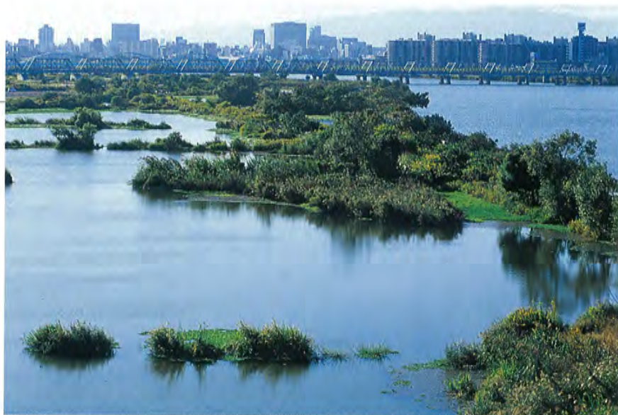
●淀川左岸に広がる城北ワンド群の下流部(菅原城北大橋下流)。右上方は淀川の本流。左奥に見える2つの水平方向の筋のようなものは、土砂がたまりその上に植物が育った水制。手前の水制は一部が水に隠れている
