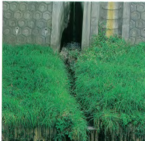
●生活排水の流れ込む排水口に設置された木炭(下2点)
