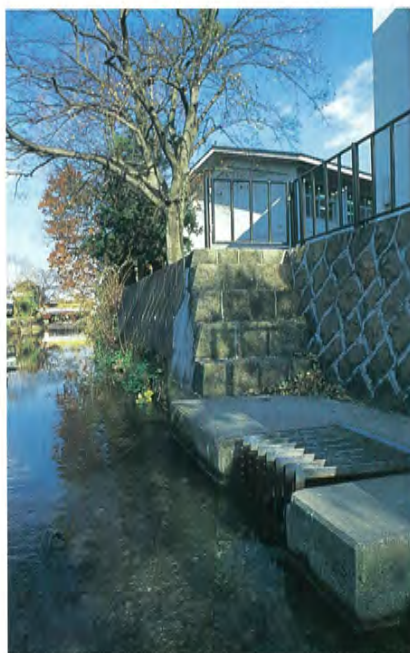
●巴波川に設けられた浄化施設の取水口(左)と放流口(右)
