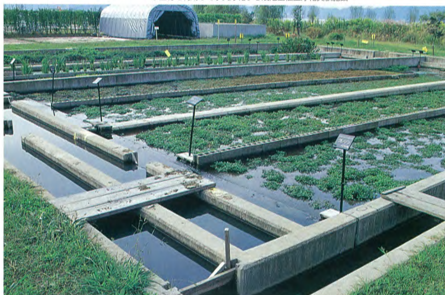
●植物を利用して水質浄化する浅池型植生浄化実験施設
