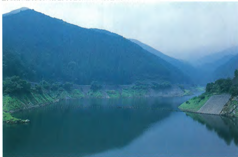
●有間ダムの建設された名栗村から名栗湖と名づけられた貯水池。夏季は洪水に備えるため、満水位より水位を17m下げて貯水量を調整している
