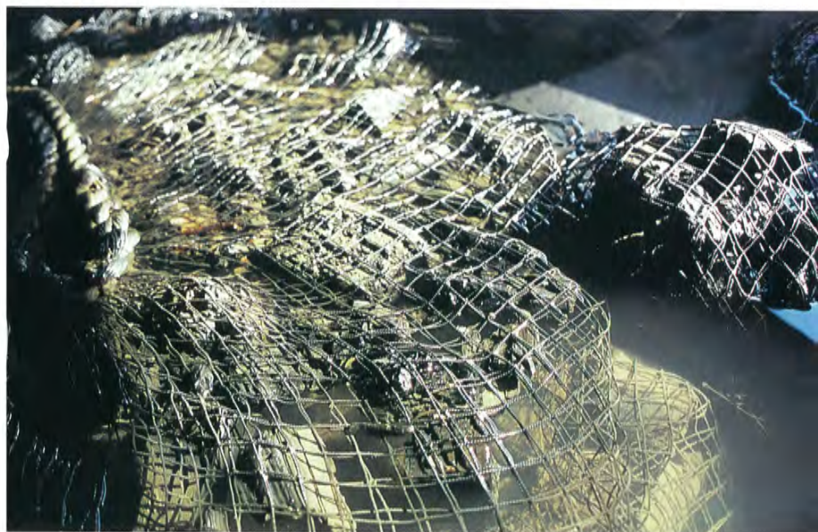
●浄化槽に充填(じゅうてん)されている浄化用の木炭
