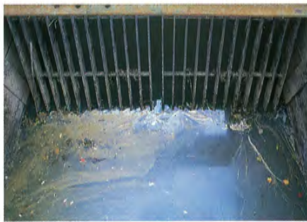
●浄化前の水路
