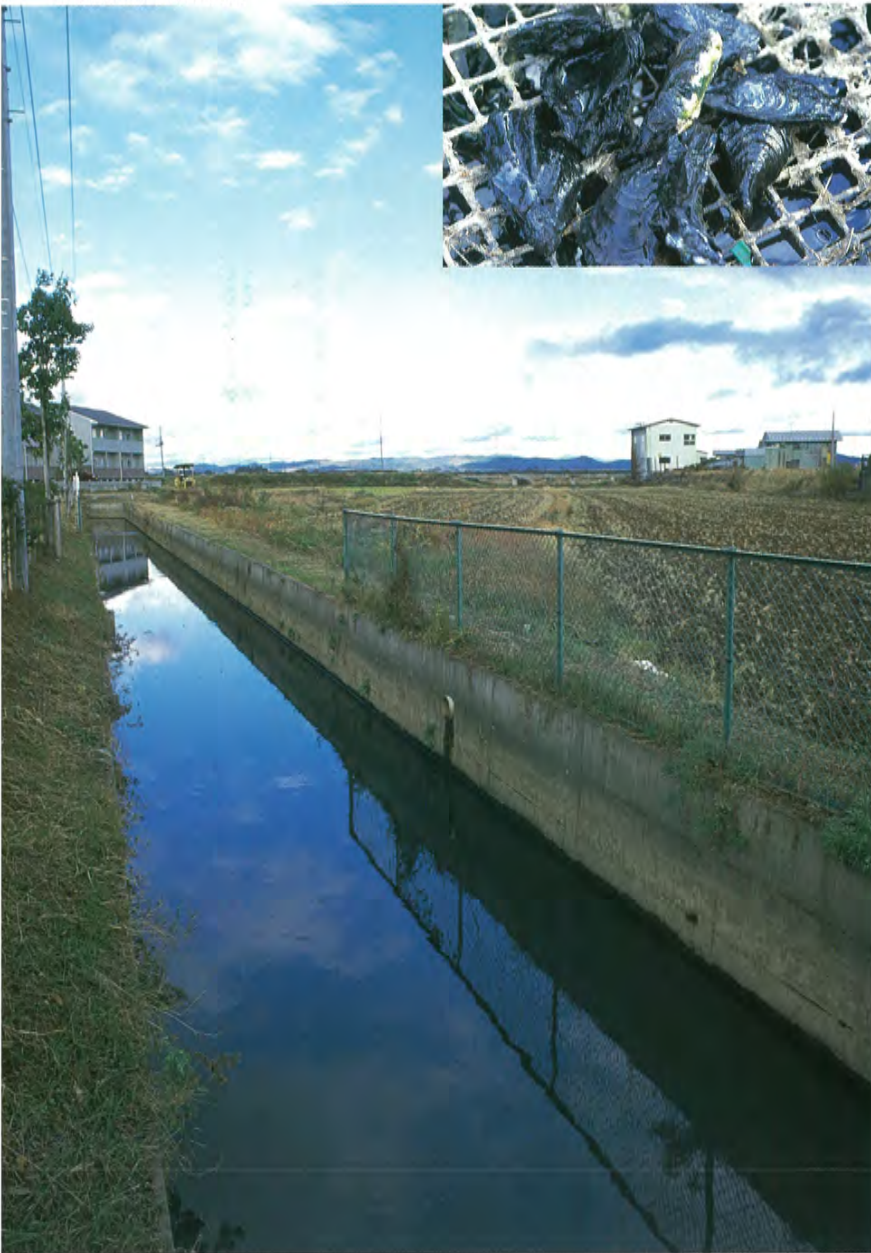
●浄化後の水の流れる水路
