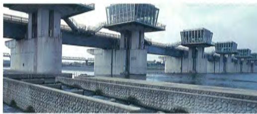
●宮ヶ瀬ダムで貯水した水を相模大堰では現在、毎秒2m 3 取水して、神奈川県たくさんの家庭に水道水を供給している
