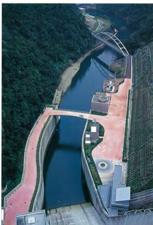
●宮ヶ瀬ダムのすぐ下には、最大発電出力24,200kWの第一発電所(右手)がある。この下流に最大発電出力1,200kWの第二発電所がある
