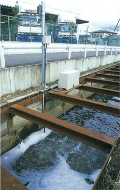
●浄化効果を高めるために三カ所で曝気している
