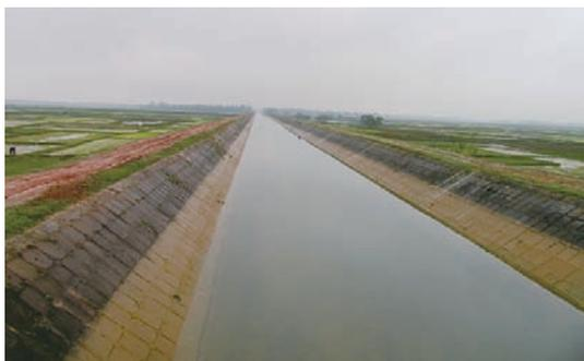
上:灌漑用水路、ケゴダムなどで開発された灌漑用水は、海岸線と並行な用水路網により配水される。また、取水のため盛土方式となっている。さらに、道路は浸水を避けるために盛土構造となっている。このため、氾濫した洪水はこれらの盛土の影響を受けるため、氾濫流への影響評価が不可欠である。
