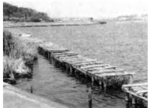
写真 4.5 粗朶沈床
