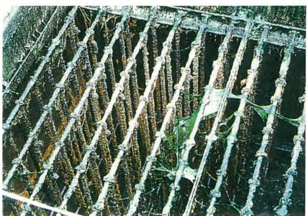
写真3・4 紐状接触材（リングレース）の設置状況
