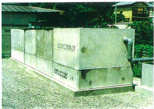
写真3・1 生駒浄化施設（沈砂池、接触酸化槽、多孔性コンクリートブロック槽）
