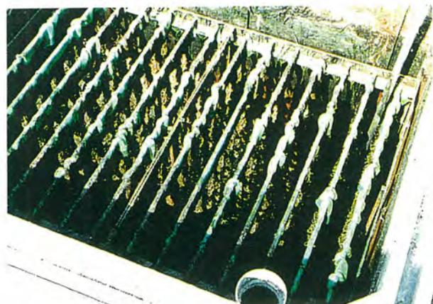
写真3・3 紐状接触材（バイオモジュール）の設置状況
