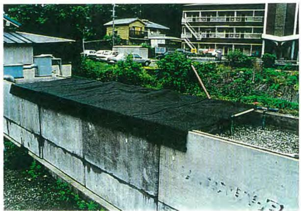
写真3・5 遮光用不織布による接触槽の遮光
