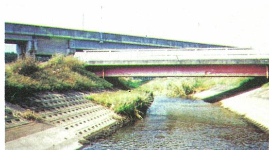
写真8：田園部の中河川、傾斜の緩い護岸が施工されている
